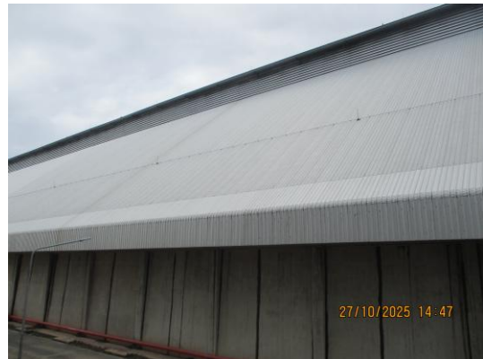
รูปที่ 1 อาคารผนังเมทัลชีท (Metal Sheet)
